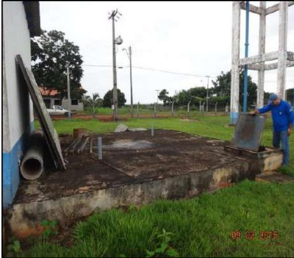
Figura 42. RAP 01 utilizado como poço de sucção da EEAT.
