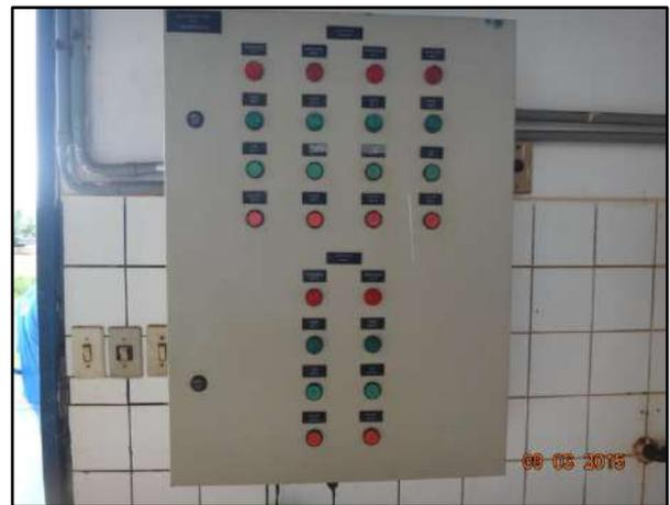
Figura 34. Painel elétrico para acionamento da bomba dosadora.
