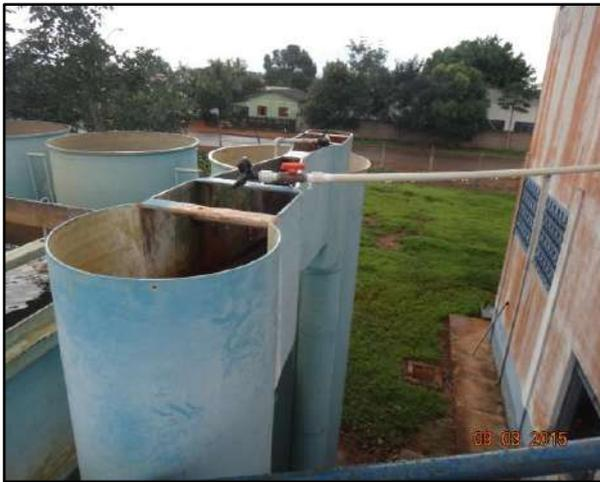
Figura 31. Dosagem de coagulante no Medidor Calha Parshall.
