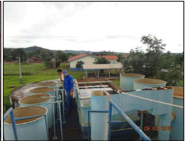
Figura 32. Floculação, decantação e filtração.
