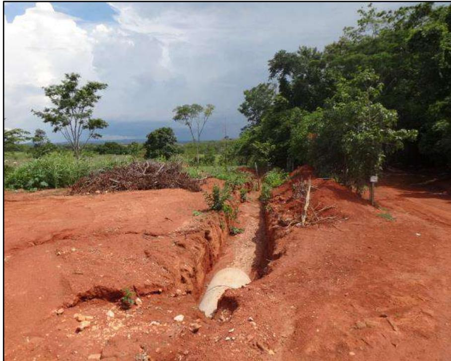
Figura 59. Ponto de lançamento das águas pluviais na Sede Municipal de Corumbiara.
