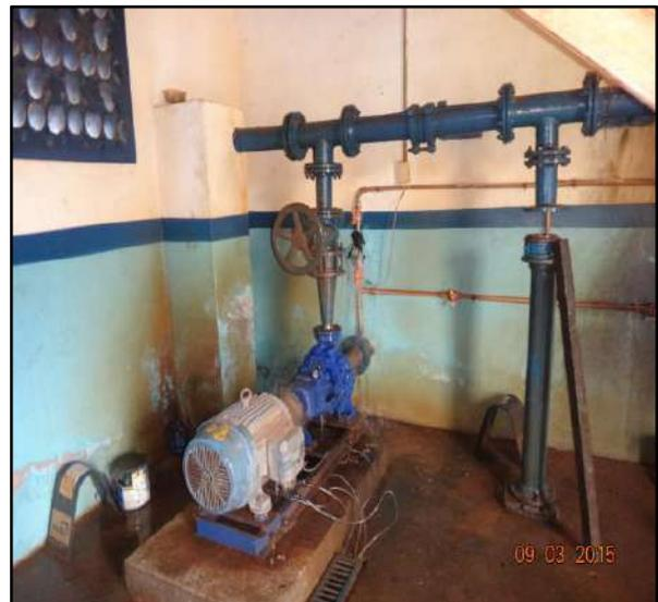
Figura 29. Conjunto moto-bomba da estação elevatória de água bruta.
