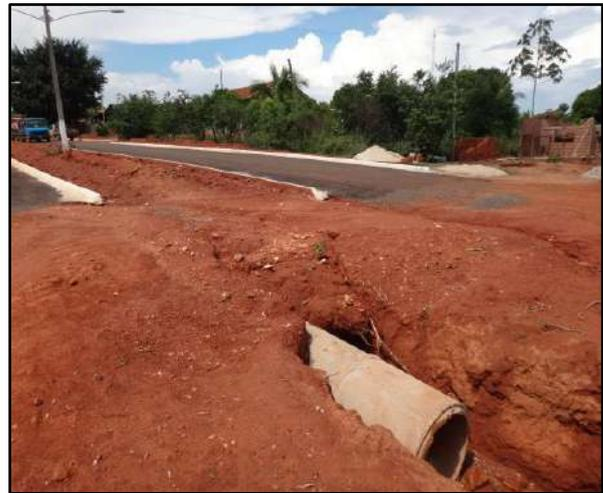
Figura 58. Dispositivo de microdrenagem subterrânea.
