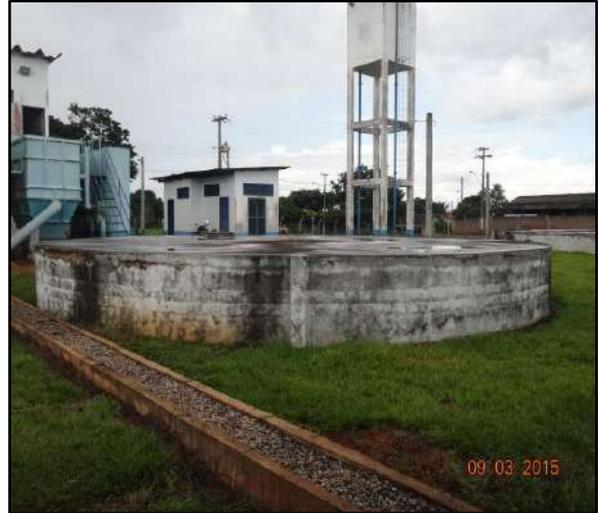
Figura 43. RAP utilizado para armazenamento de água tratada.
