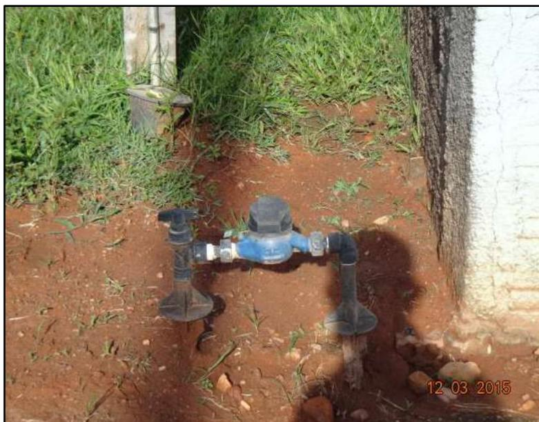
Figura 45. Instalação de hidrômetros.
