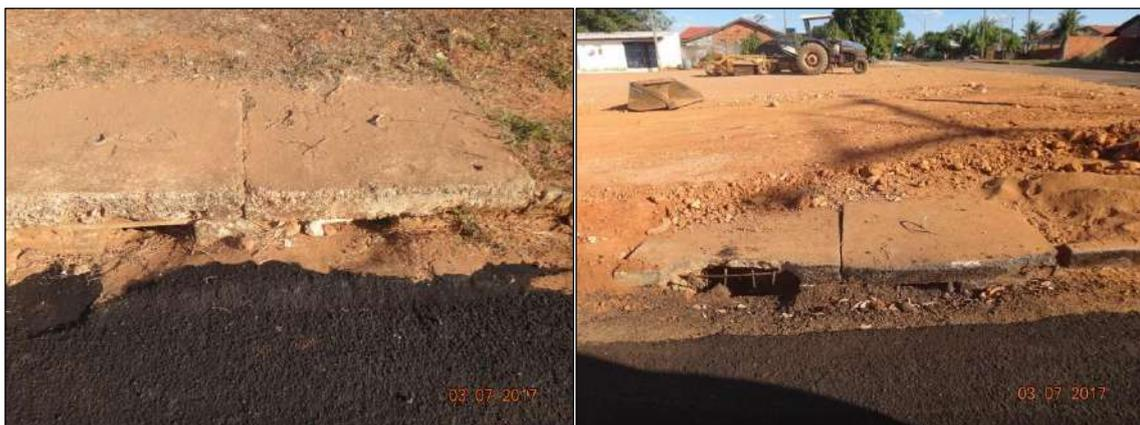
Figura 100. Boca de lobo mal dimensionada
