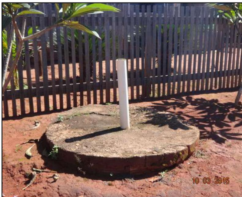
Figura 50. Fossa negra para eliminar esgoto doméstico (instalação individual).
