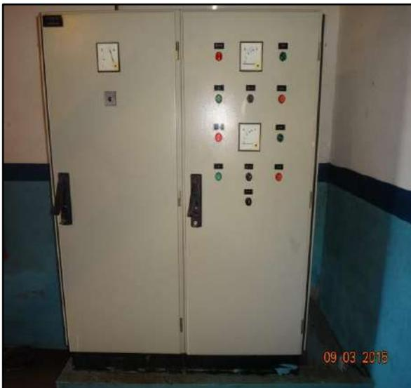
Figura 28. Painel elétrico de acionamento do conjunto moto-bomba.
