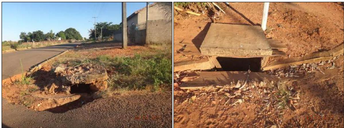
Figura 101. Dispositivos coletores de águas pluviais danificados e sem grade de proteção no município de Corumbiara
