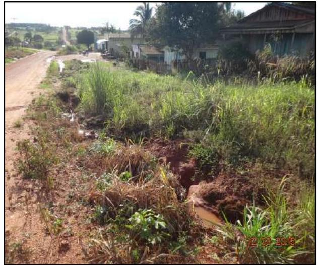
Figura 63. Ocorrência de erosão no emissário da micro drenagem.
