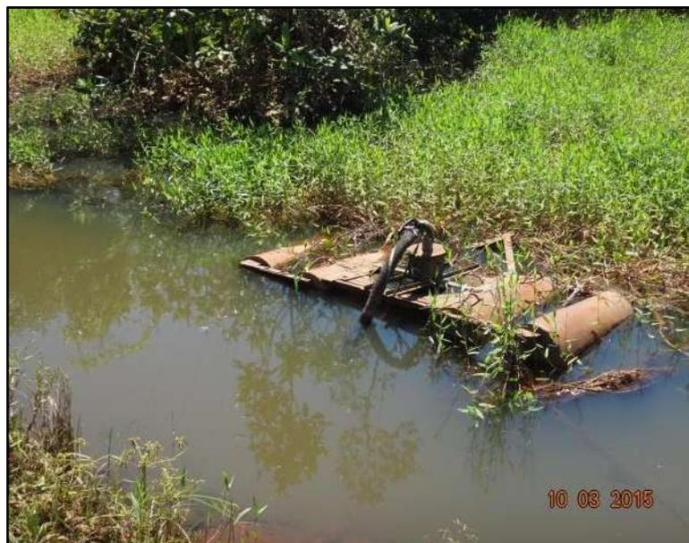
Figura 21. Bomba de captação de água da SAC do Distrito Vitória União.
